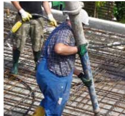
Wände und Decke werden ausbetoniert und mit Ortbeton verfüllt.
