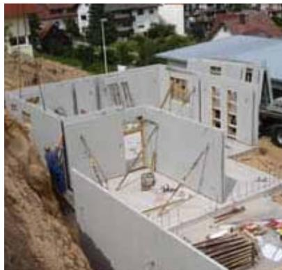
Anschließend werden die Wand- und Deckenelemente montiert.
