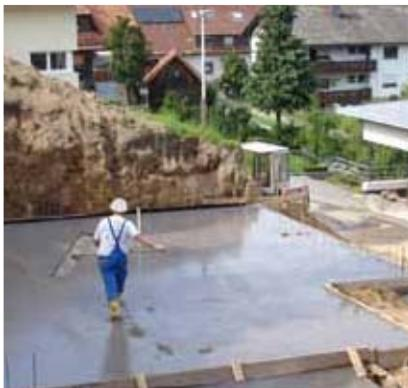
Der Kellerbau beginnt mit dem Betonieren der Bodenplatte.
